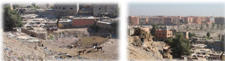
Figure N° 7. Photos quartier menaçant ruine au secteur El Koudia
