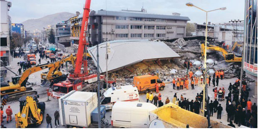
Fotoęraf 5: Depremde Yıkılan Bayram Otel
