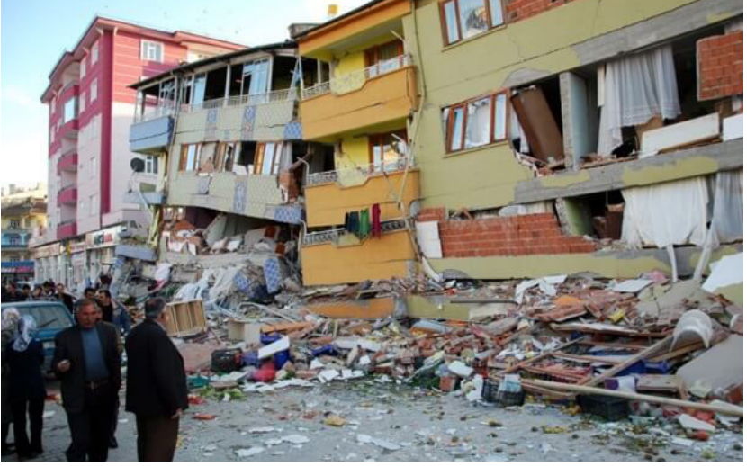
Fotoęraf 1: Depremde Yıkılan Binalar
