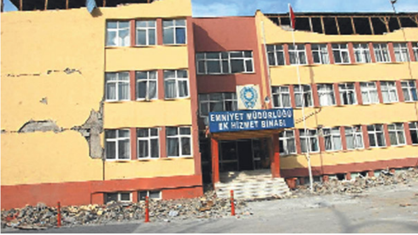
Fotoğraf 7: Kamu Binası
