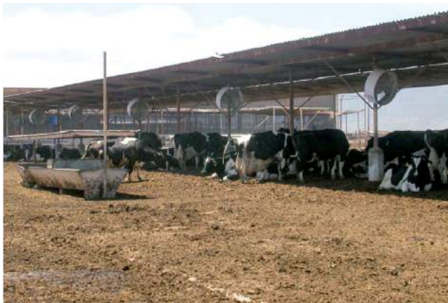
Figura 6.15: Instalações com refrsecamento por aspersão e ventilação forçada em condições semiáridas. Fonte: Acervo pessoal do autor.
