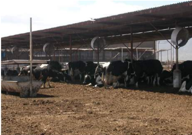
Figura 6.10: Currais com ventiladores instalados no teto (ventilação forçada). Fonte: Acervo pessoal do autor.
