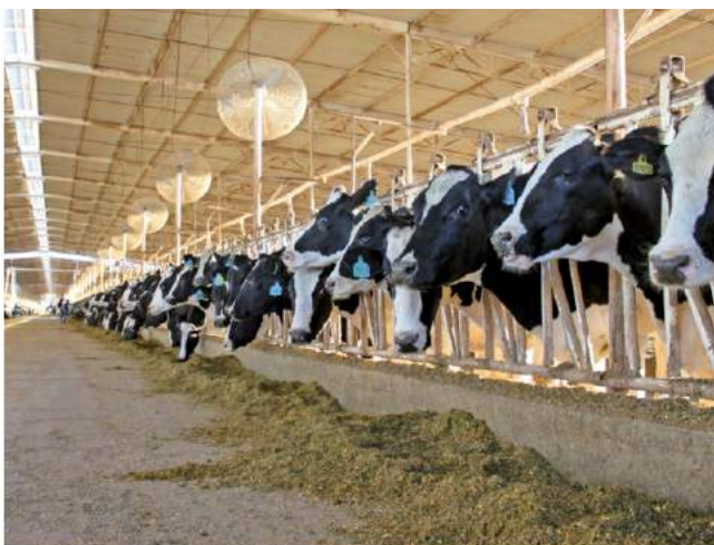
Figura 6.12: Currais com ventiladores instalados no teto (ventilação forçada). Fonte: Acervo pessoal do autor.
