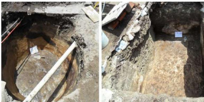
Imagen 1. Detalle de los noques. A la izquierda de forma cónica, a la derecha rectangular.
