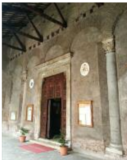
Fig. 13 - Roma, S. Vitale: narcece. Si distinguono gli archi tamponati della pentafora della facciata originariamente aperta
