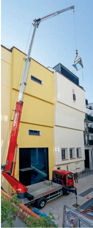
Bild 5: Das gefüllte Wasserprisma wird aufs Dach des DRM gehieft
