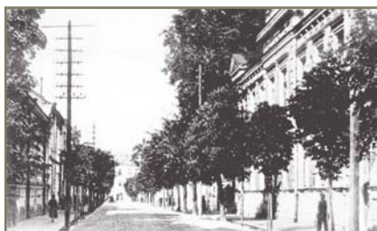
⇒ Pałac Tryllingów (po prawej) i widok na ul. Warszawską
