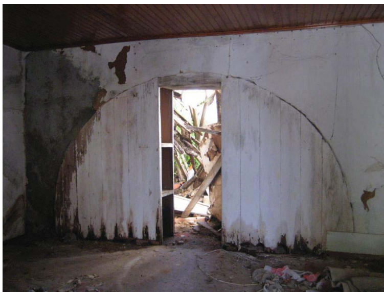
Figura 23. Arcos de volta inteira da estrutura dos Estaus. Autor: Fernando Sanchez Salvador.
