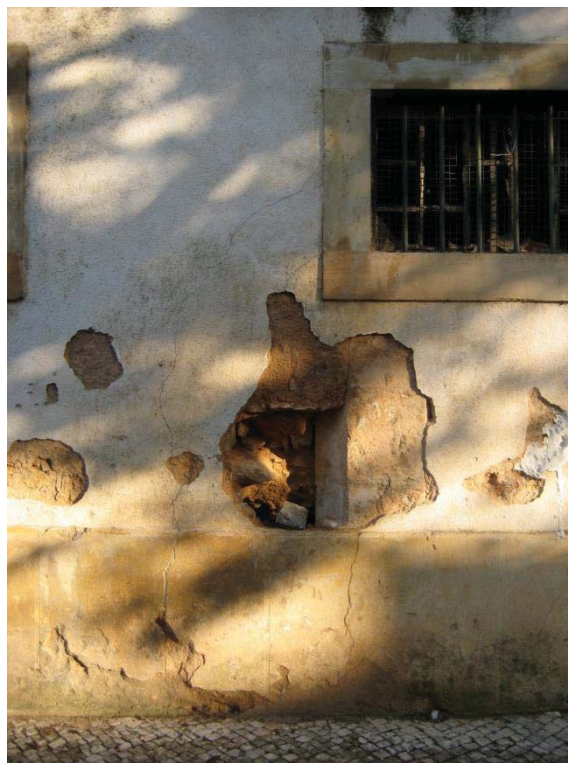
Figura 22. Trechos arquitetónicos que restam dos antigos edificios dos Estaus na actualidade na Rua dos Arcos fachada sul. Autor: Fernando Sanchez Salvador.
