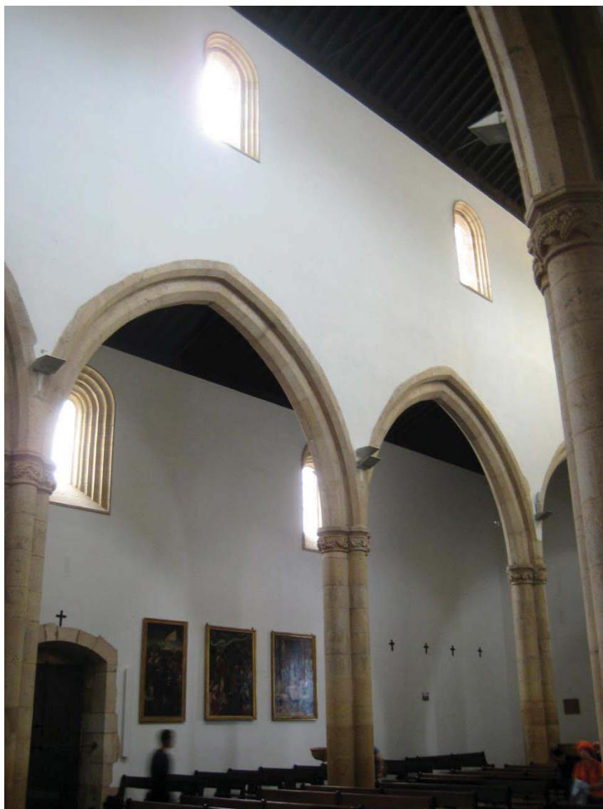
Figura 2. Santa Maria dos Olivais - Construção das naves central e laterais. Autor: Fernando Sanchez Salvador.
