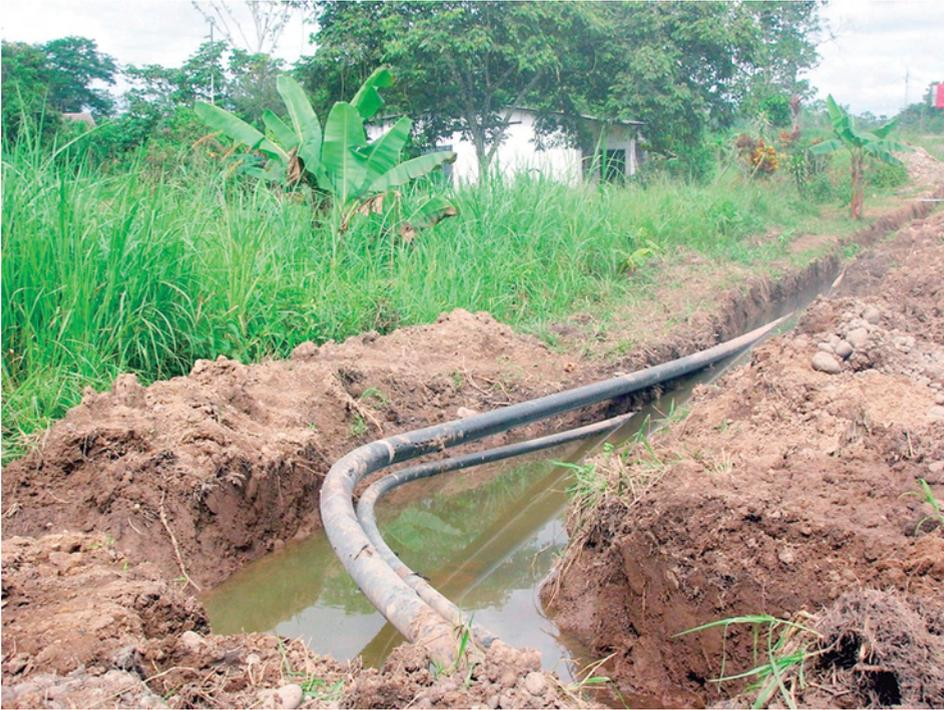
*Figura 10.1. Impactos del extractivismo petrolero en la Amazonia ecuatoriana. Ductos plásticos, en malas condiciones, tendidos en la localidad de Lago Agrio (provincia Sucumbíos), conectando pozos con centros de bombeo y reconducción. Las repetidas roturas generan contaminación de suelos y aguas. Fotografía del autor.*
