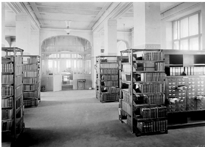
fig. 8 - Sala cataloagelor. În fundal se remarcă blocul bibliotecarilor.
