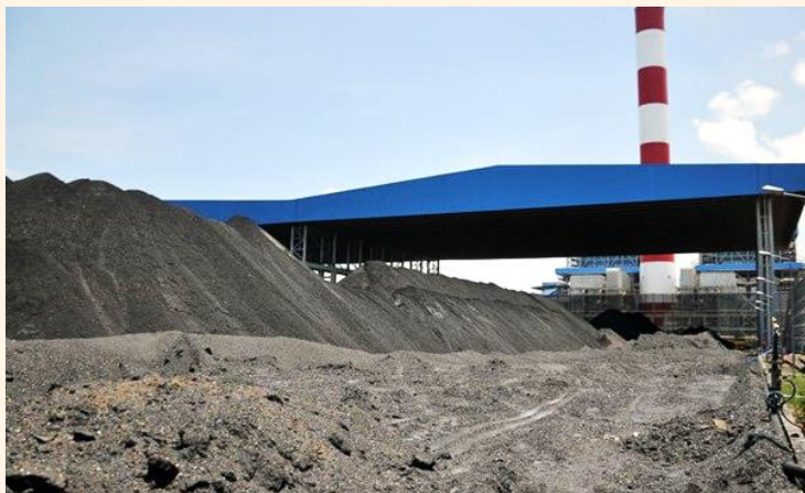
Trước đây, tro xỉ từ các nhà máy nhiệt điện chủ yếu được sử dụng vào việc san lấp các mặt bằng.
